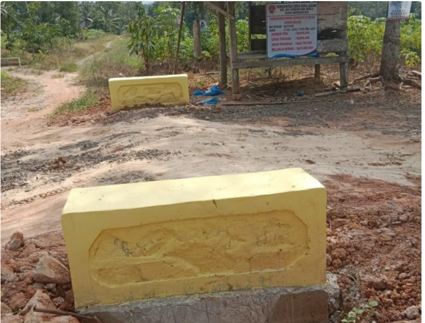
Pembangunan gorong-gorong Desa Suka Agung
